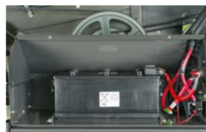
12 V baterie napájí palubní elektroniku a elektroniku motoru. Je umístěna ve snadno přístupné schránce.
